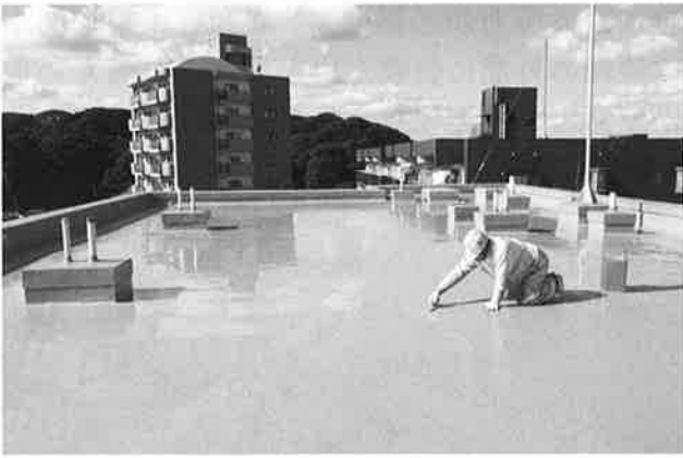
屋上ウレタン防水工事施工中
