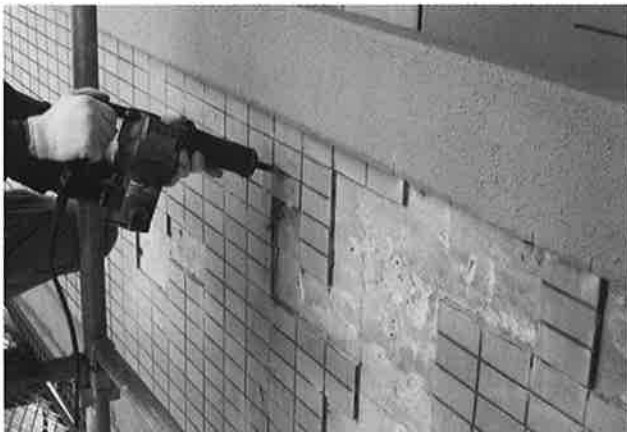
磁器タイル浮き部のハツリ状況
