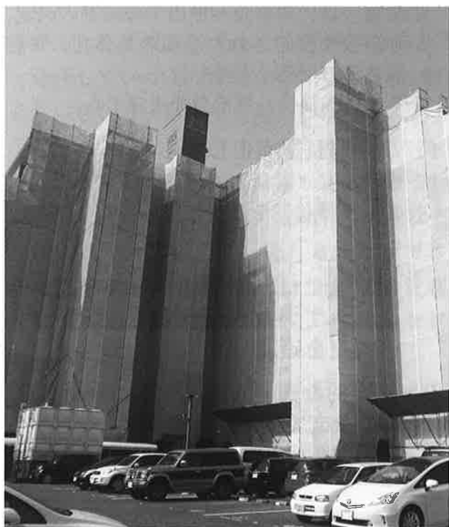
仮設足場組立完了
