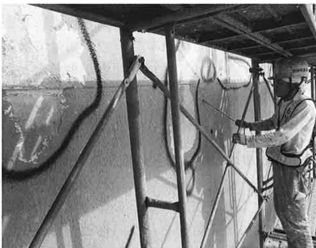
躯体調査マーキング状況
