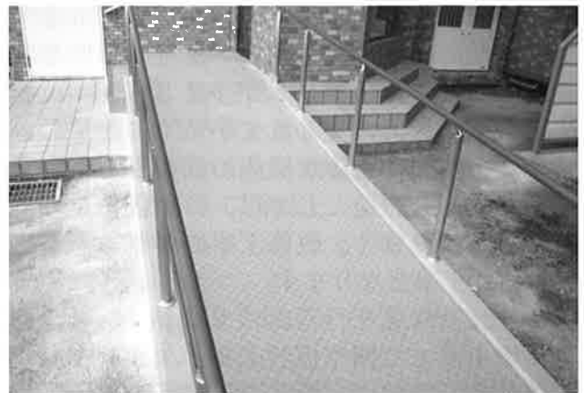
スロープ設置
