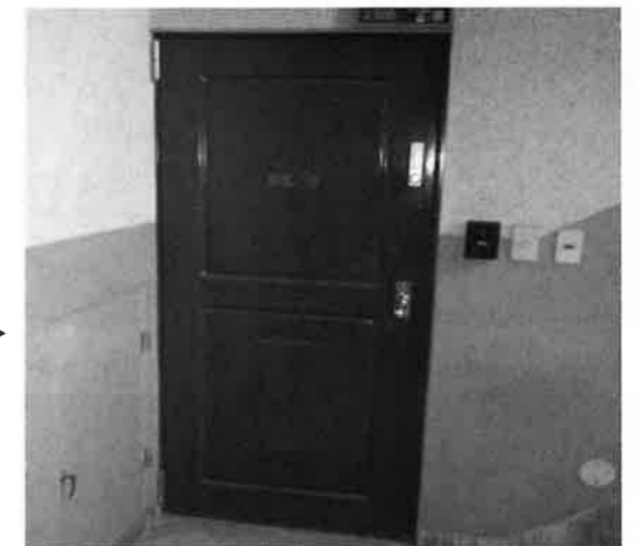
玄関ドア交換後
