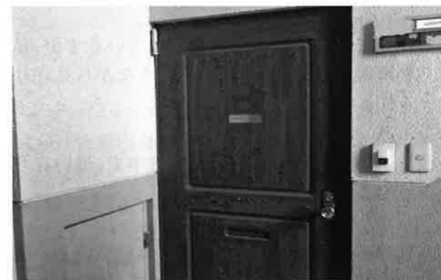
玄関ドア交換前
