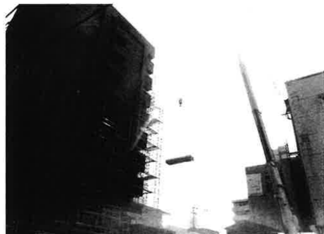
「架設工事が始まりました」
