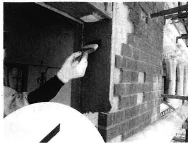
「外壁タイルの補修工事」
