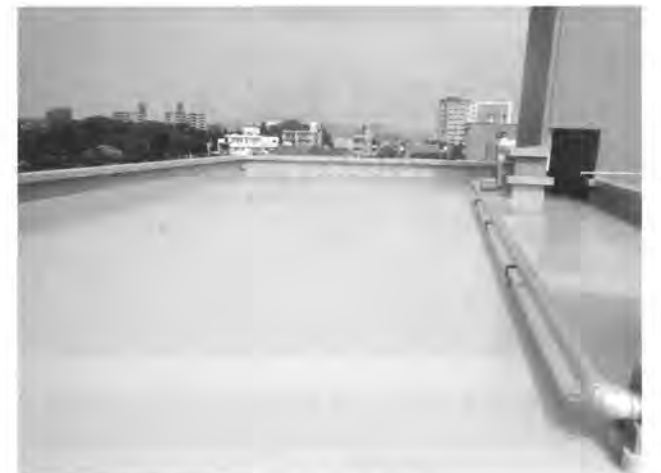
屋上防水完了
